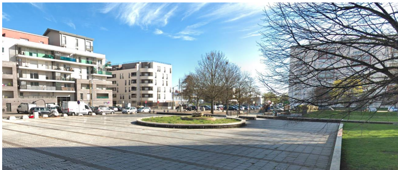
FIGURE 4 PHOTOGRAPHIE DU SITE AVANT TRAVAUX
